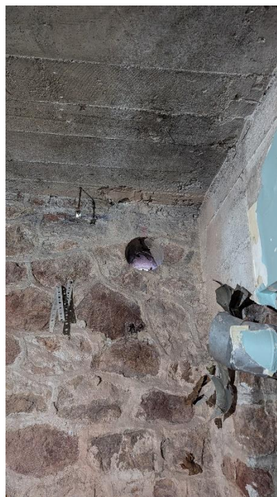
Figure 2 : Percement pour ventilation
