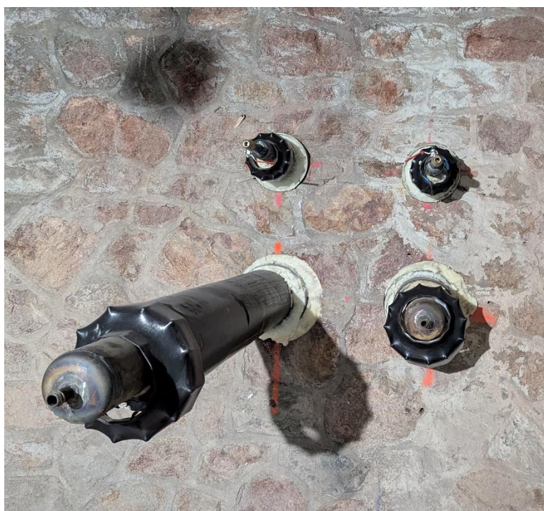
Figure 1 : Tuyaux réseau chauffage en attente
